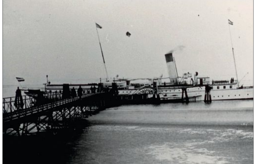
Diese Landungsbrücke wurde für die großen Dampfer des „Norddeutschen Lloyd“ gebaut. Diese hatten einen größeren Tiefgang als die üblichen Schiffe und fuhren die Route Helgoland – Bremerhaven. Der Zugang über den Steg zu den Schiffen erfolgte von der südlichen Seite der Warthalle. Bei den Norderneyern hieß der Steg „Helgoland-Anleger“.
