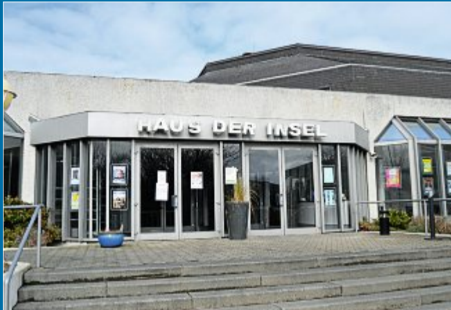
SICHERHEIT Keine Nutzung des Gebäudes mehr möglich
