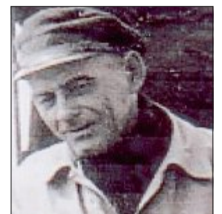
Willy de Boer (146) um 1950 als Schachtmeister und Vorarbeiter bei Küstenschutzarbeiten am ehemaligen Soldatensteindamm. De Boer war bei seinen Kollegen sehr beliebt und er hatte ein großes Fachwissen. Den Tod seines Sohnes Wilhelm, der am 8. Mai 1945 bei einem Tieffliegerbeschuss ums Leben kam, hat er nie überwunden.
