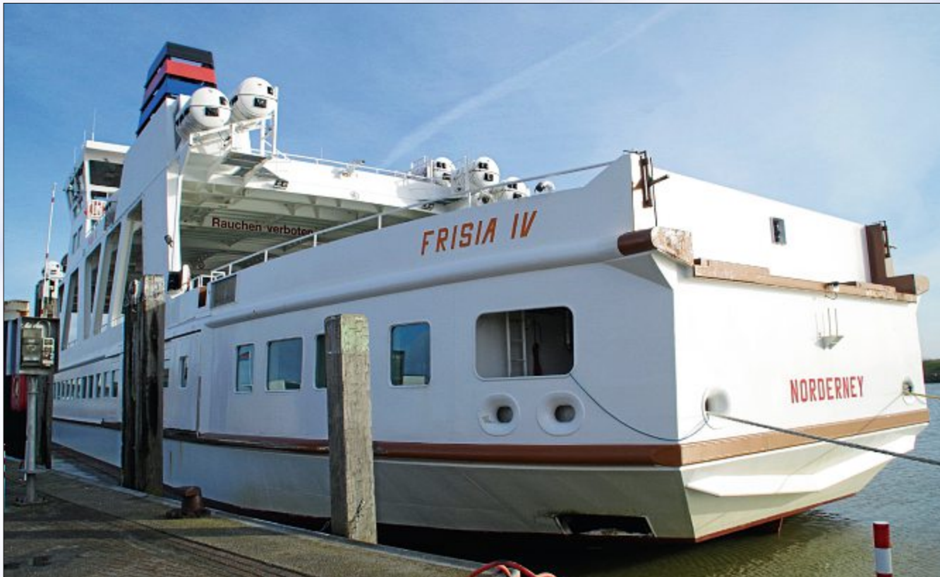
Im Norderneyer Hafen liegt die „Frisia IV“ aus der Flotte der Reederei Norden-Frisia in dieser Woche an der Kaimauer. Nach der Werftzeit in Oldersum werden Reparaturen und Wartungsarbeiten auf der Insel vorgenommen.
