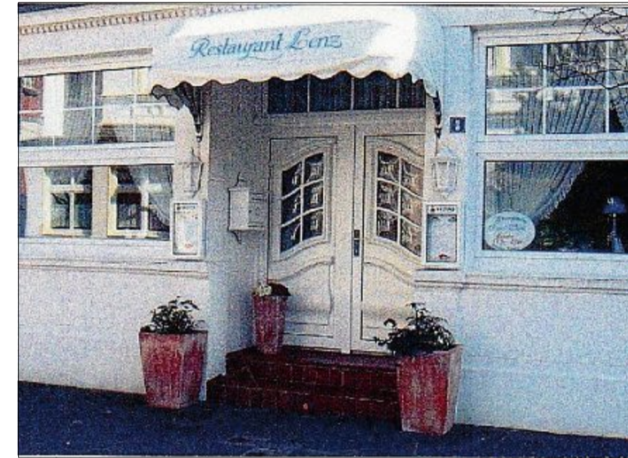
Nach dem Umbau zum Restaurant stand das Haus für ein gepflegtes Restaurant im englischen Landbaustil. Ab 1988 trug das Haus den Namen „Restaurant Lenz“. Das blaue Hausnummerschild stammte noch aus der Gründerzeit. Damals waren die Schilder der Straßen und die Hausnummern aus emailliertem Blech gearbeitet. Blau-Weiß war gängig, man kann schon die Norderneyer Farben darin erkennen.
