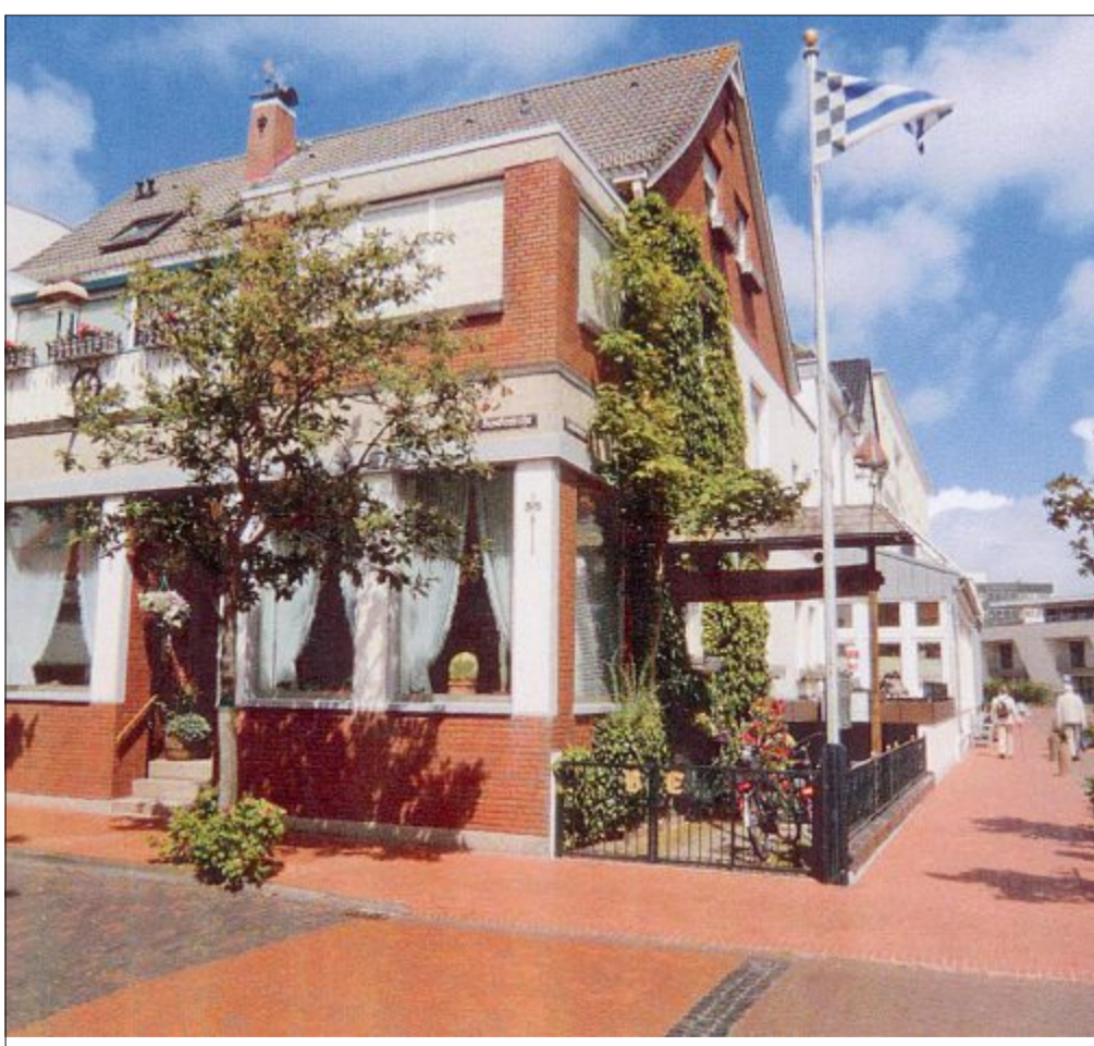
Das „Huuus Ostend“ in der Benekestraße 56, Eigentümer: Ursula und Bonno Eberhardt. Bonno Eberhardt hatte sich zu seinem 50. Geburtstag einen sieben Meter langen Fahnenmast aus Aluminium gewünscht. Schlossermeister Axel de Boer hat den passenden Masthalter, den sogenannten Köcher, nach alter Manier hergestellt. Eberhardt, von Beruf Klempnermeister, hat eine Kupferkugel angefertigt, die von seinem Ortshandwerkerkollegen, dem Malermeister Lothar Zilles, für „ein Appel und Ei“ vergoldet wurde. Diese Kugel ziert heute den Mastkopf. Der Fahnenmast mit der Norderneyer Fahne in der Größe von einem mal eineinhalb Metern soll symbolisieren: „Hier wohnt ein Norderneyer.“
