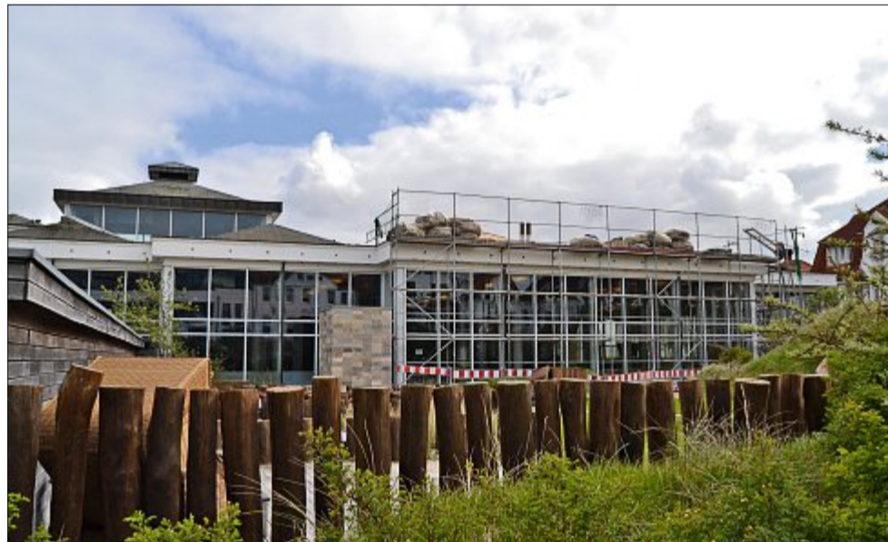
Zurzeit wird das Dach auf dem Spaßbad provisorisch geschlossen.
