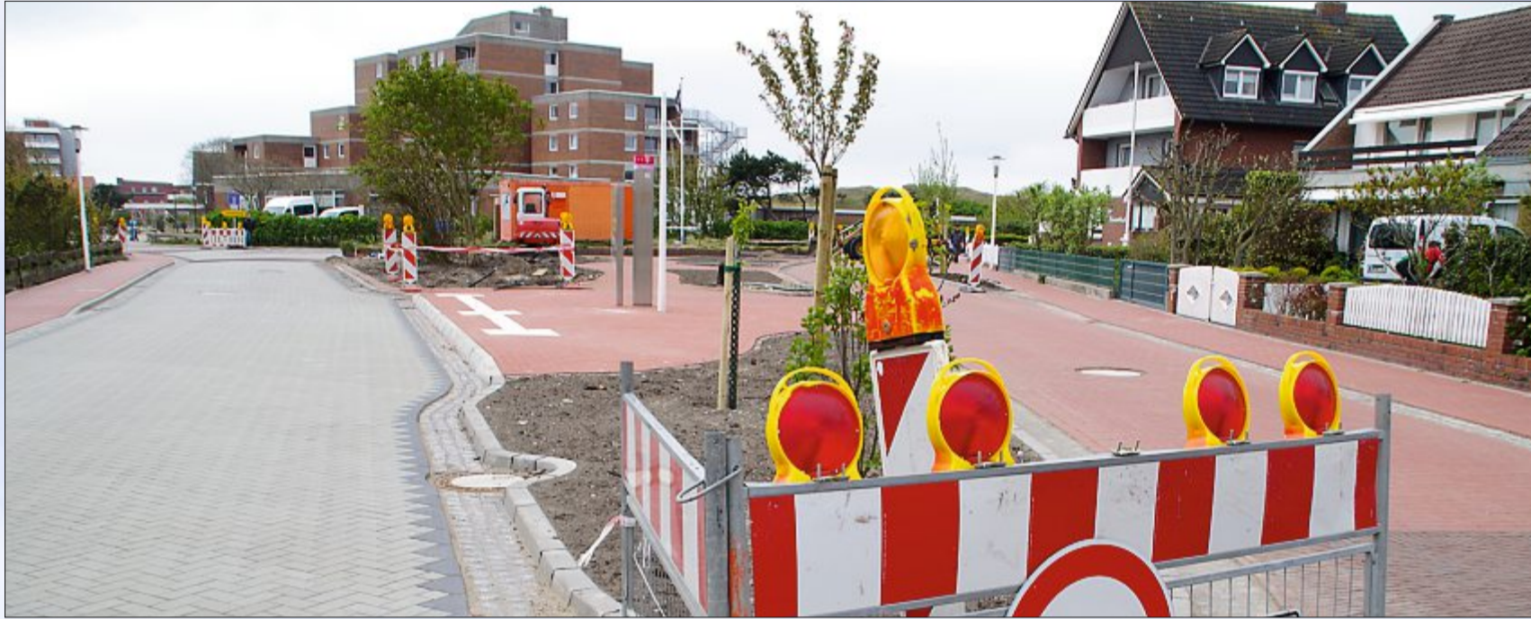
Der Kreuzungsbereich Nordhelmstraße / Bürgermeister-Willi-Lührs-Straße ist bereits gepflastert, und die Beete sind bepflanzt.
