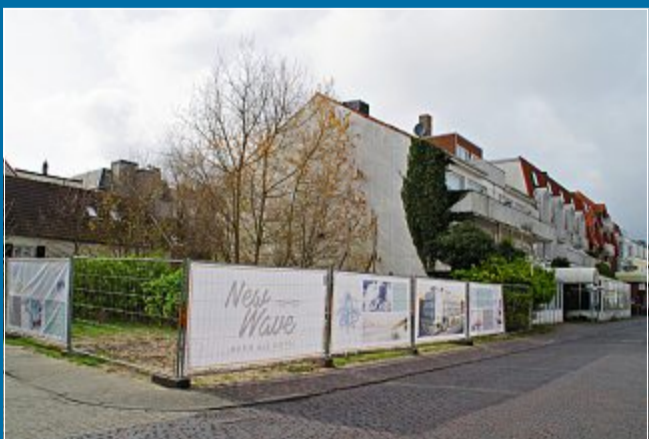
Bau „Pro Urban GmbH“ aus Meppen will Gebäudekomplex errichten
