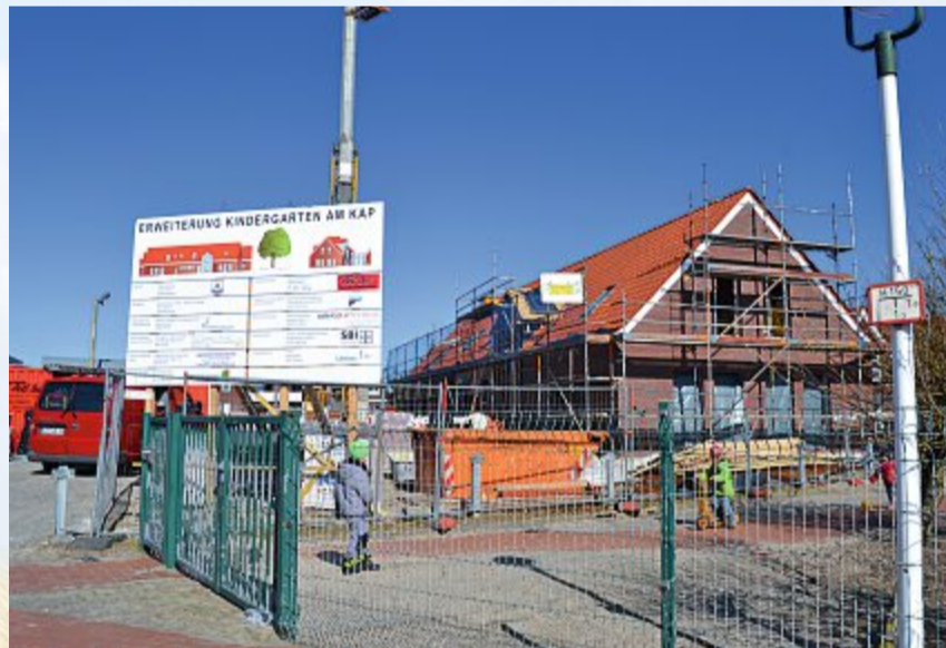
Der Anbau des Kindergartens am Kap ist schon sehr weit gediehen.
