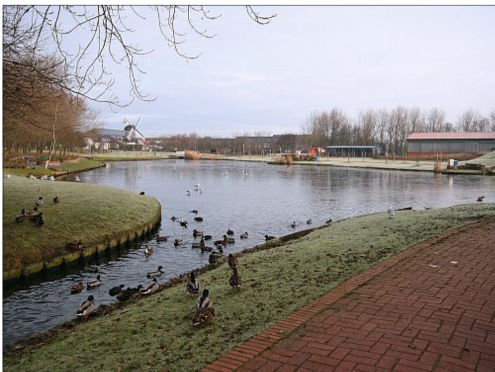
Es gibt eine Trennung von Schmutz- und Regenwasser in der Kanalisation auf Norderney. Der Gondelteich fungiert als Regenwasser-Rückhaltebecken. Im Hintergrund die Inselmühle. ARCHIVFOTO
