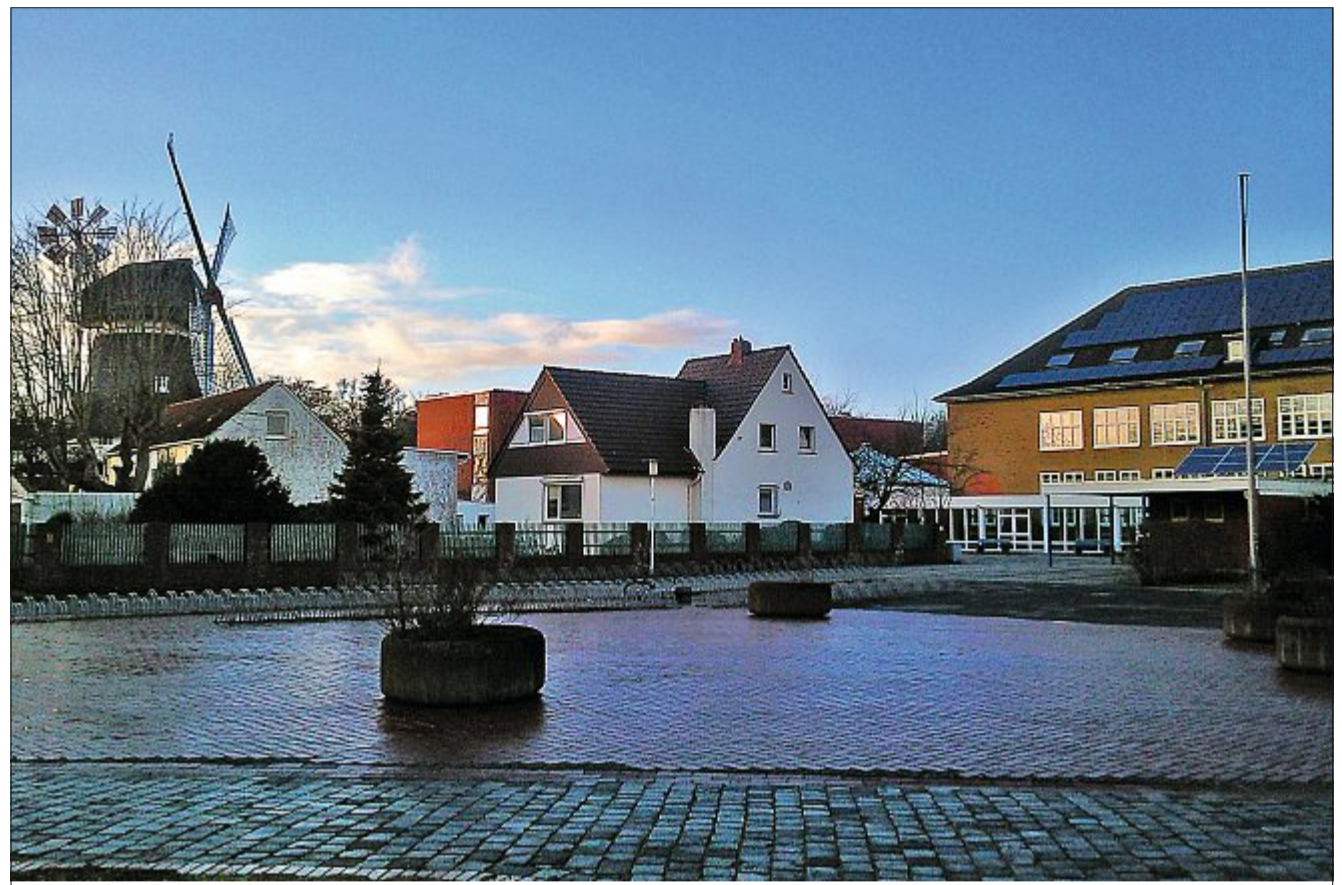
Die Gebäudekomposition mit der Mühle und den dazu gehörigen Gebäuden und die Kooperative Gesamtschule Norderney (KGS), so wie sie aktuell besteht. FOTO: PUGATSCHOV
