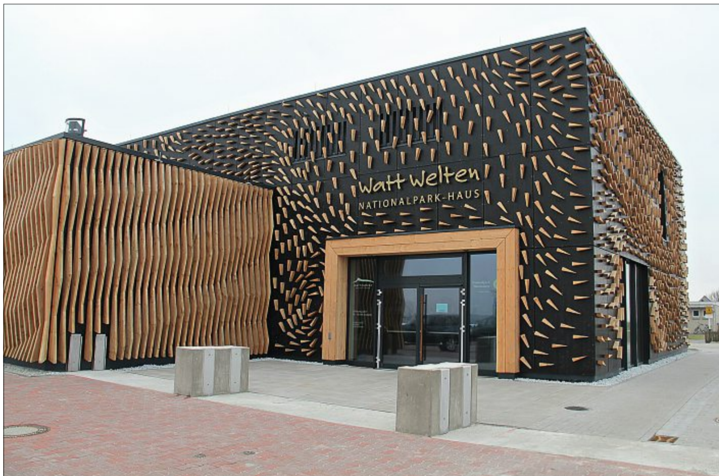
Die umstrittene Holzfassade der WattWelten hat nun offenbar Risse bekommen.
