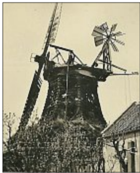
Die zum Skelett ausgebrannte Inselfmühle.
