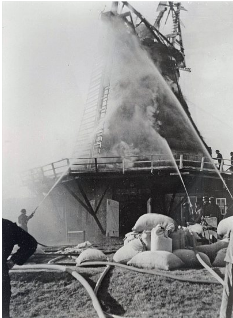
Großalarm am 24. April 1951: Die Inselfmühle brennt. Die britische Militärfeuerwehr hilft der örtlichen Freiwilligen Feuerwehr bei den Löscharbeiten.
