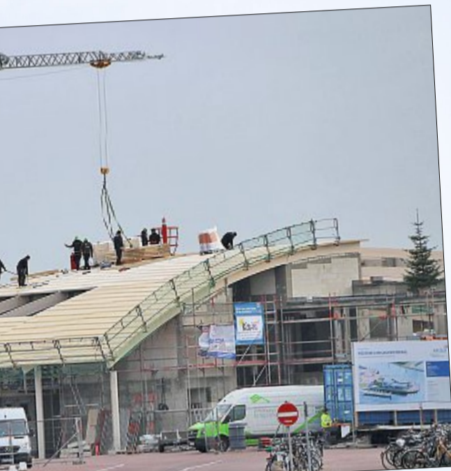
Die Bauarbeiten am Hafen schreiten voran. FOTOS (3): NOUN
