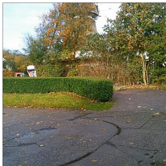
Südlich der Mühle: die vor dem Zweiten Weltkrieg angelegte Straße am ehemaligen Kasernentor; die Führungsschienen der Torflügel sind noch gut sichtbar.
