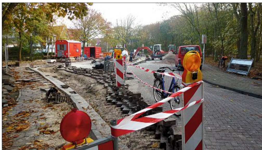
Die Bushaltestelle „Rosengarten“ wird behindertengerecht ausgebaut. Die Bordsteinkanten werden dafür angehoben. Zudem kommt eine Überdachung auf die Mittelinsel. FOTO: FASTENAU
