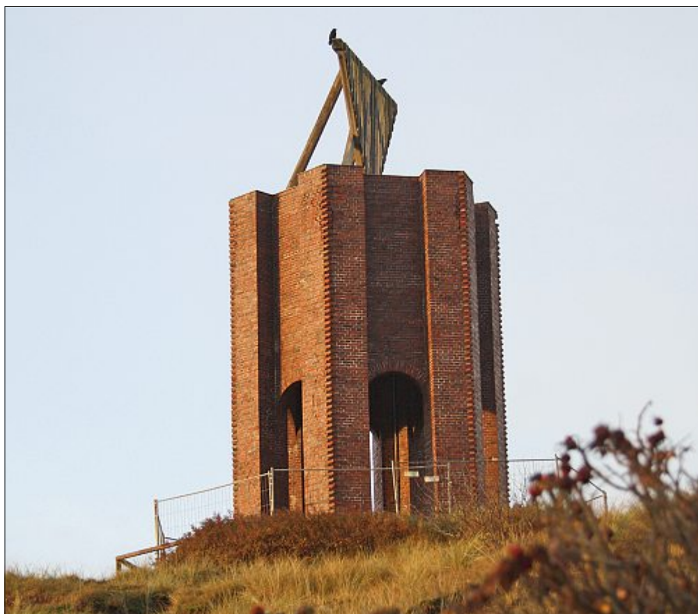
Das Norderneyer Wahrzeichen wurde 1848 erstmals aus Holz erbaut. Bald folgt der vierte Wiederaufbau, nunmehr mit einem Betonkern und einer Verblendung aus Klinkern. FOTO: RASS
