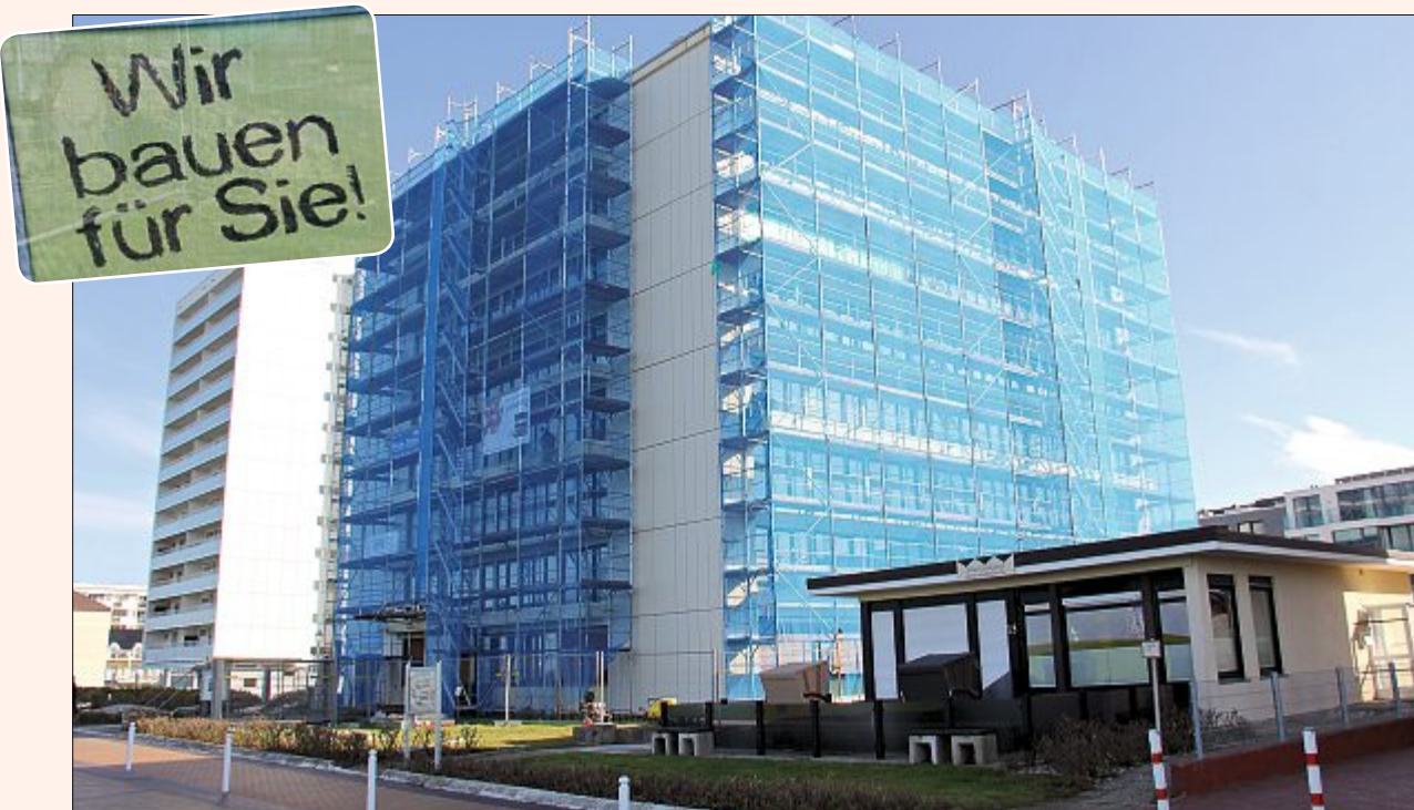
Der Kaiserhof ist immer der aggressiven Seeluft ausgesetzt. Er wird saniert.
