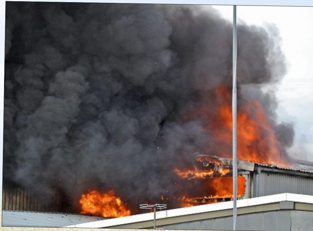
Abplatzende und umherfliegende Teile des Gebäudes machen die Situation ebenfalls gefährlich.
