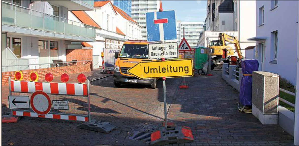
In der Halemstraße wird kräftig gebaut.
