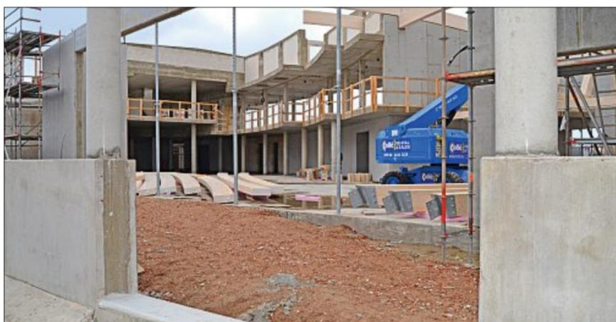
Die Flutschutzsture um das Gebäude herum haben Durchlässe, die bei Bedarf mit Aluminiumbalken verschlossen werden können.
