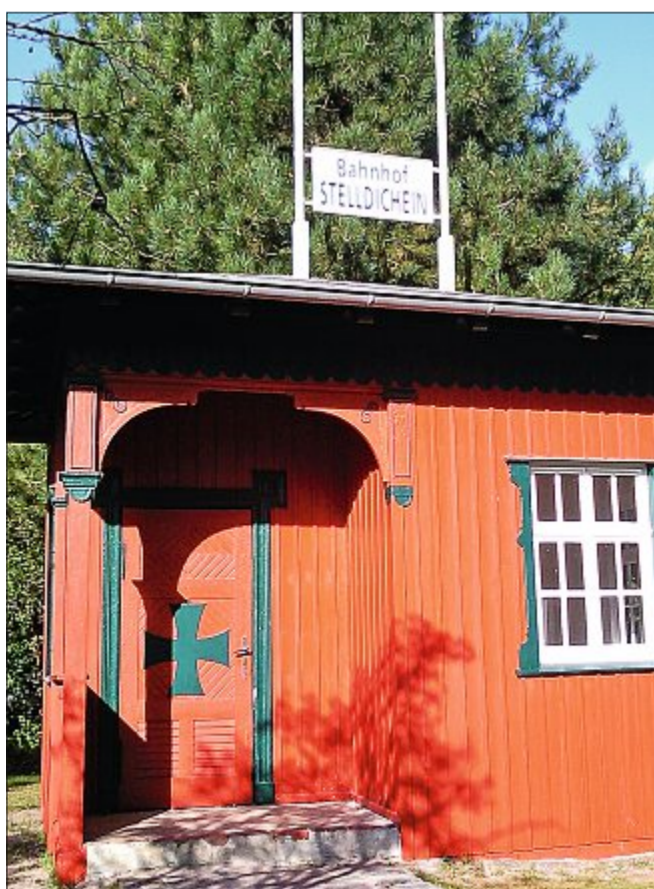
Auch heute noch als Relikt des Ersten Weltkriegs zu besichtigen: die Gedenkstätte zur Inselbahn am Bahnhof Stelldichein.
