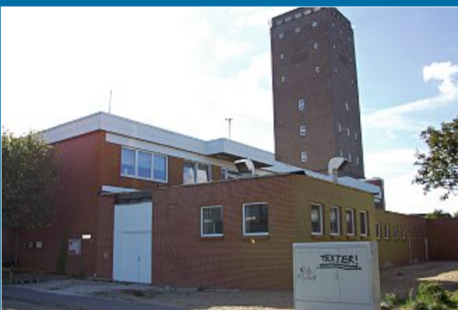
HANDWERK Am Feuerwehrhaus wird an- und umgebaut
