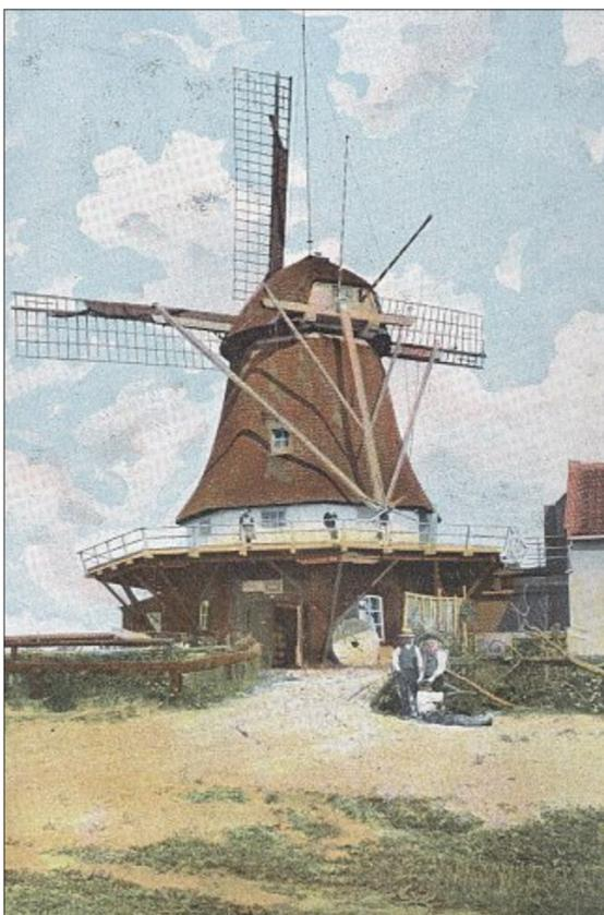
Die Norderneyer Mühle um 1900: Hier ist der Steert sehr gut zu erkennen, mit welchem die Mühle „in den Wind“ gedreht wurde.
