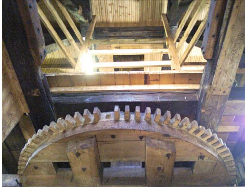
Im Inneren der Mühle: ein Blick in die oberen „Etagen“.
