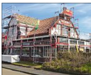
Die Meierei wird komplett renoviert. FOTO: FASTENAU
