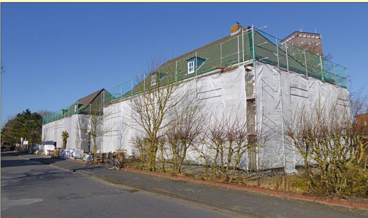
Noch verhüllt zeigen sich die Gebäude an der Mühlenstraße, die derzeit energetisch saniert werden. Sie bekommen ein Wärmeverbundsystem, neue Fenster und eine Überarbeitung der Dächer.
