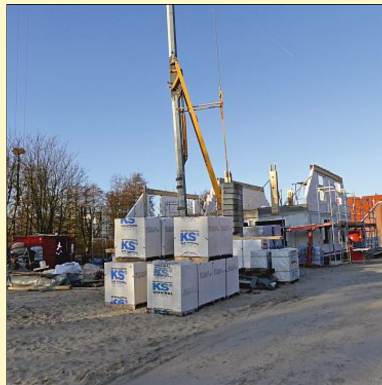
Am Südwesthörn entstehen zehn Doppelhaushälften für Norderneyer. Zwei Bauherren haben schon angefangen.
