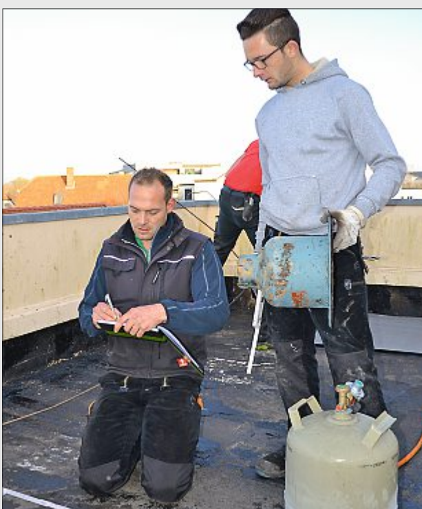
Sanierung der Flachdachentwässerung. FOTOS (2): SÖRRIES
