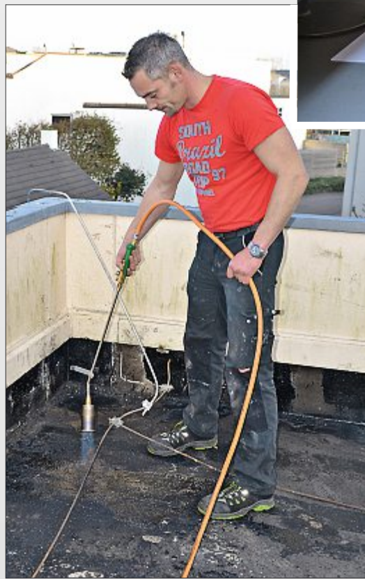
Ganz wichtig für eine sichere Dachabdichtung ist die funktionierende Unterkonstruktion.
