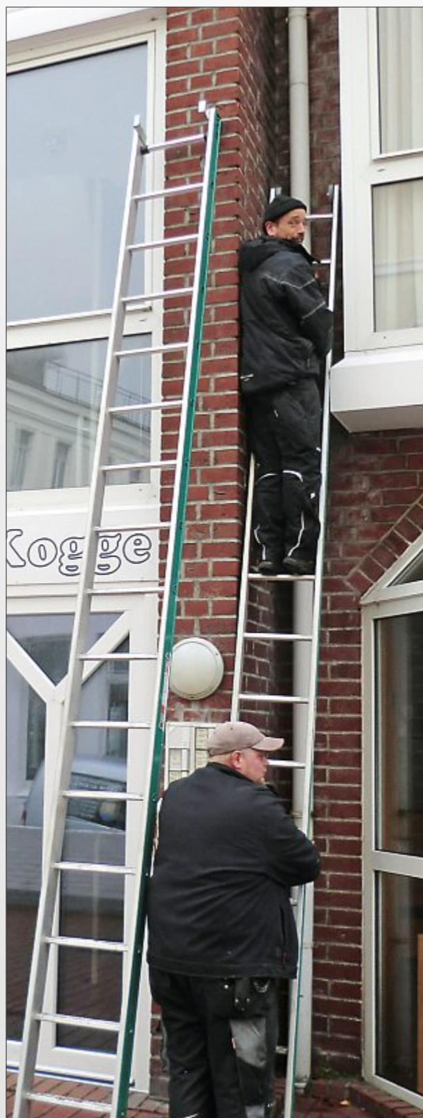
Eines der Zweier-Teams beim Erledigen von Wartungs- und Reparaturarbeiten der Dachentwässerung.
