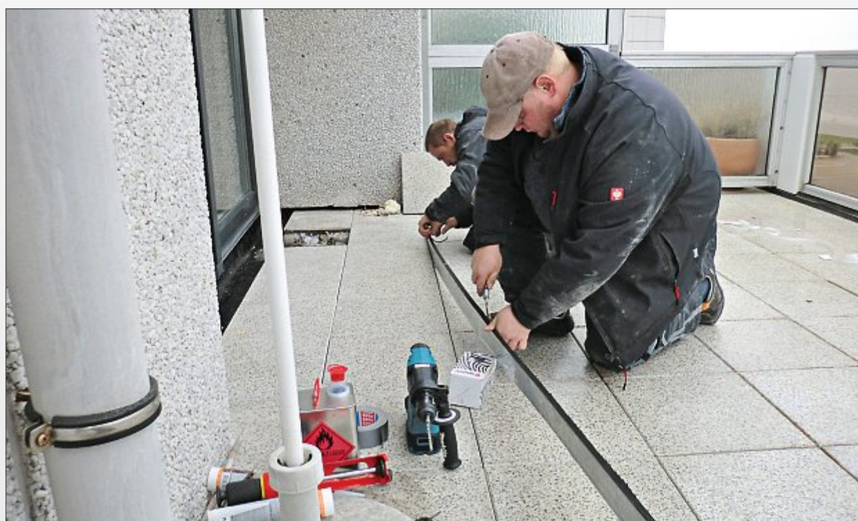
Auch beim Austausch von Fensterelementen sind Dachdeckerarbeiten nötig. Die Zusammenarbeit zwischen Tischler und Dachdecker ist daher ein wichtiger Baustein des Gesamtprozesses.
