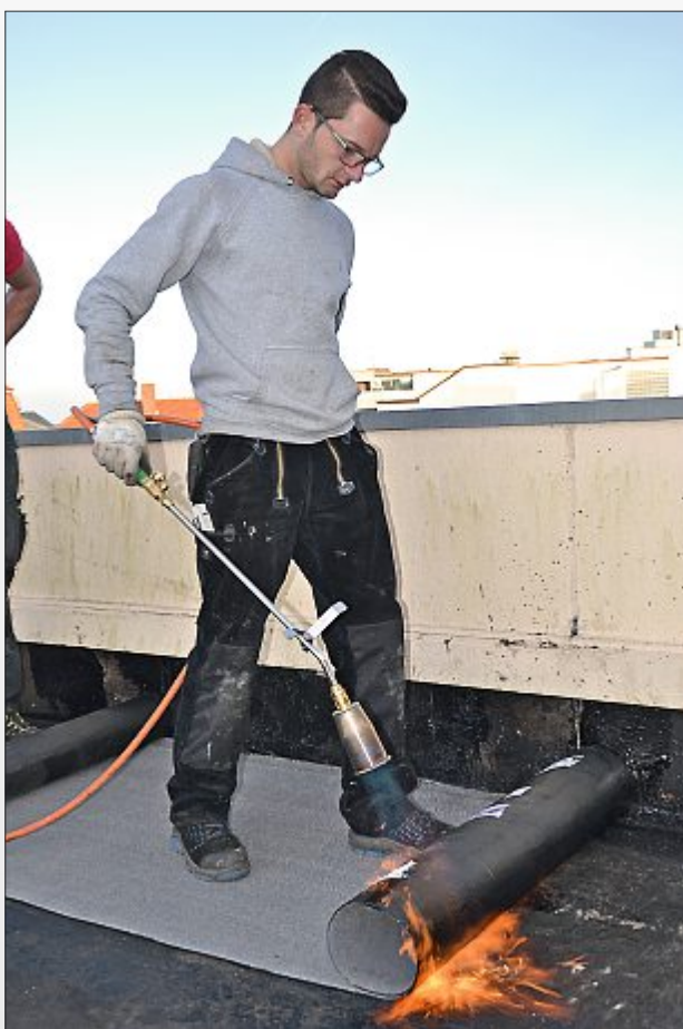
Dacharbeiten: Aufschweißen der ersten Abdichtungslage.
