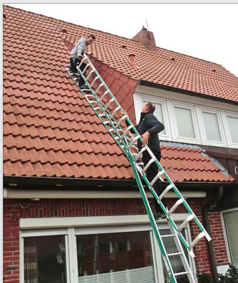
Wartungsarbeiten an einem Ziegeldach.
