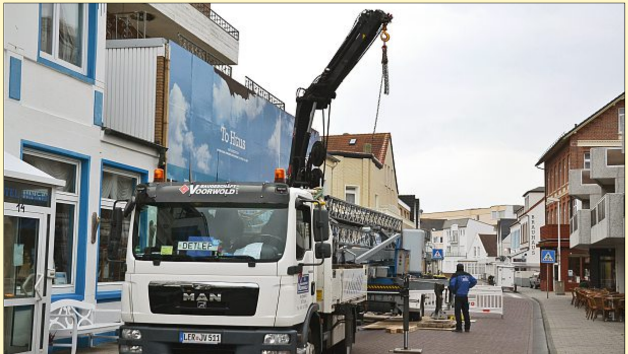
Die Bausaison auf Norderney hat begonnen. Da der Raum begrenzt ist, konzentrieren sich die meisten Baumaßnahmen auf Sanierungen, Um- und Erweiterungsbauten. FOTO: SÖRRIES
