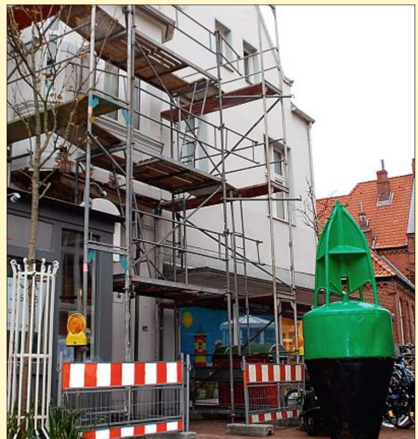
Baugerüste und Absperrungen gehören mit steigendem Bautrend mittlerweile zum gewohnten Stadtbild in der kühleren Jahreszeit. FOTO: RITTMAYER
