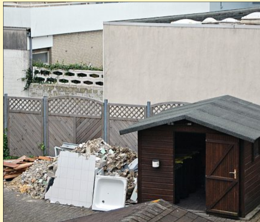
Wer das Eigenheim saniert, muss natürlich erst einmal Platz für neues Interieur schaffen. Die Fachfirmen vor Ort helfen beim Einbau. FOTO: RITTMAYER
