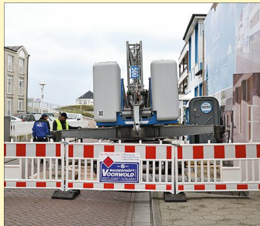
Vierorts gehen die Baumaßnahmen mit kurz- oder auch langfristigen Straßensperrungen einher. FOTO: SÖRRIS
