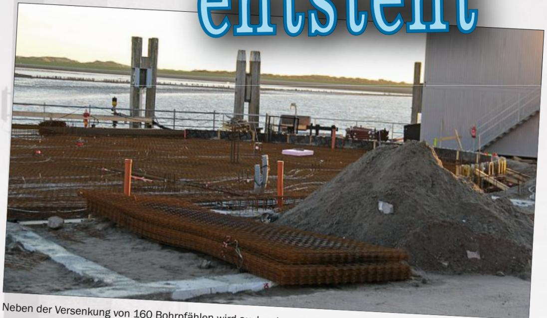
Neben der Versenkung von 160 Bohrpfehlen wird auch schon die Bodenplatte gegossen.
