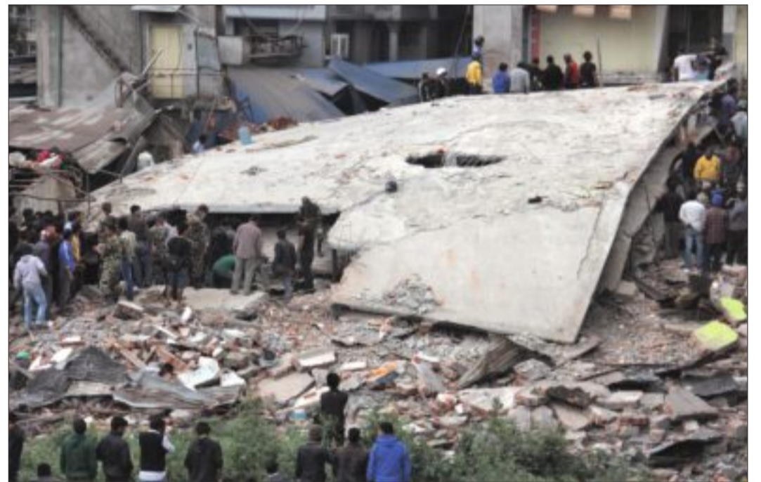
Erdbeben in Nepal. Dieses Foto zeigt ein fünfstöckiges Gebäude, das in Shovabagwati nahe der Hauptstadt Kathmandu zusammengestürzt ist. FOTO: DHIRAJ
