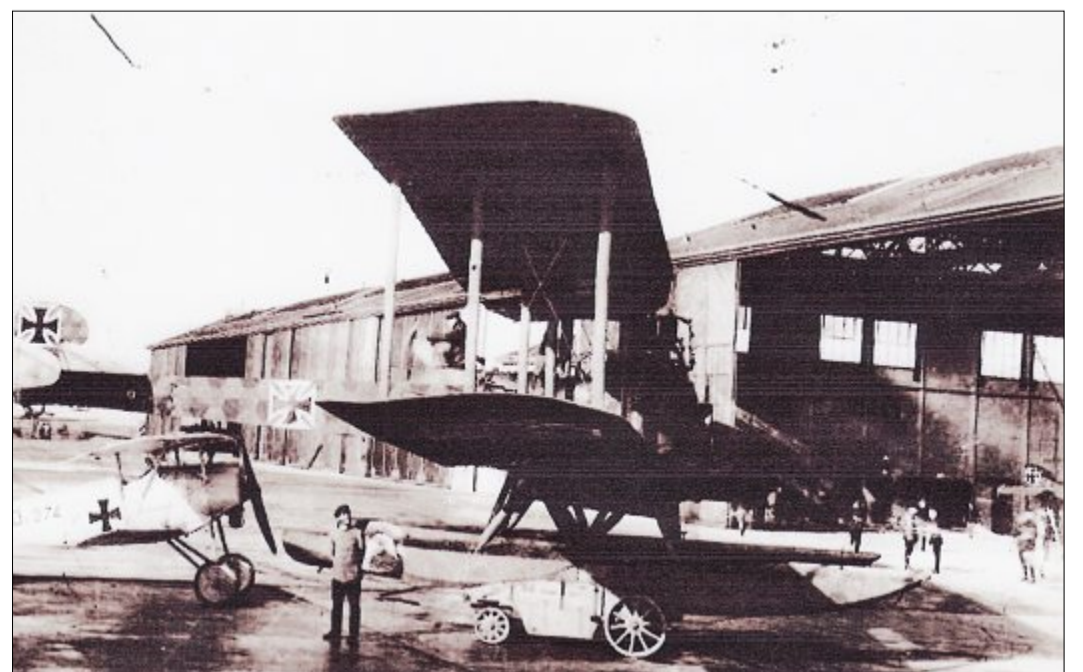
Beim Aufstellen der neuen Hallentore verloren mehrere russische Gefangene ihr Leben. Das Bild zeigt die neue Halle mit ihren riesigen Öffnungen, die durch Schiebetore geschlossen wurden.
