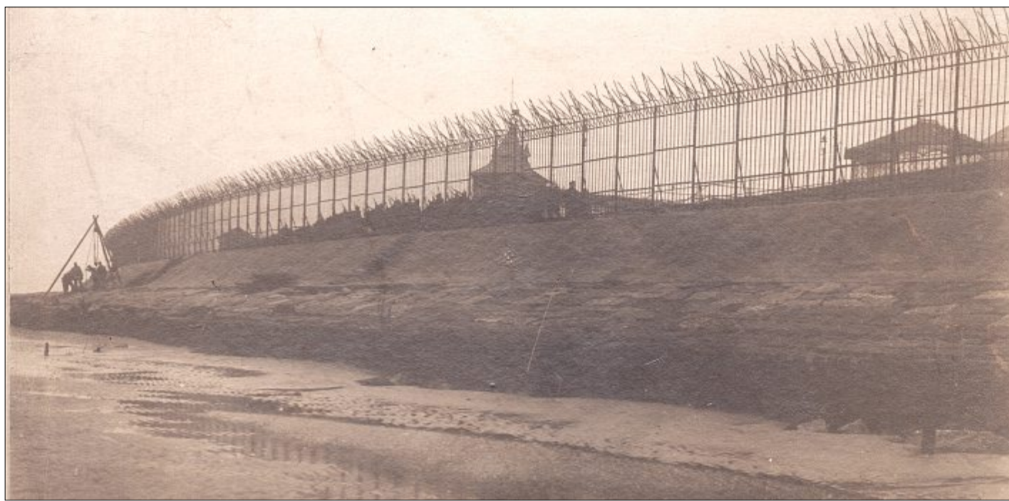
Der sogenannte Russenzaun bei den ehemaligen Strandhallen. Eine Kompanie der Inselwache marschiert auf der Promenade. Links im Bild sieht man Arbeiter, die sich am Deckwerk zu schaffen machen.
