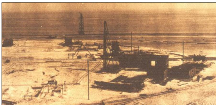
Der abgetragene Dünen sand wurde zu dem erweitertem Gelände am See-Flugplatz gefahren. Dort wurde alles verdichtet und geebnet. Zu sehen sind auch die Rammarbeiten zur Vergrößerung des Lande-Platzes zur Seeseite hin.
