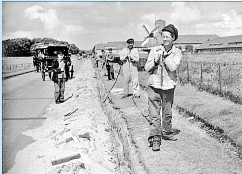
Nicht nur auf der Insel wurden fleißig Kabel verlegt. Norderney wurde zudem als erste Ostfriesische Insel an die Stromversorgung des Festlands angeschlossen.
