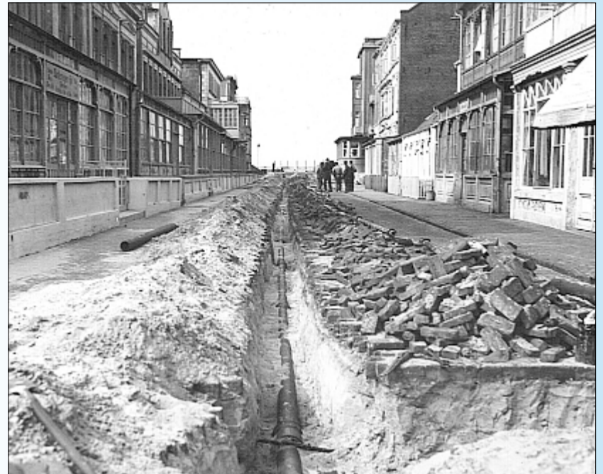
Ein altes und doch vertrautes Bild: Ohne aufgerissene Straßen geht es nicht beim Installieren und Reparieren der Leitungen.
