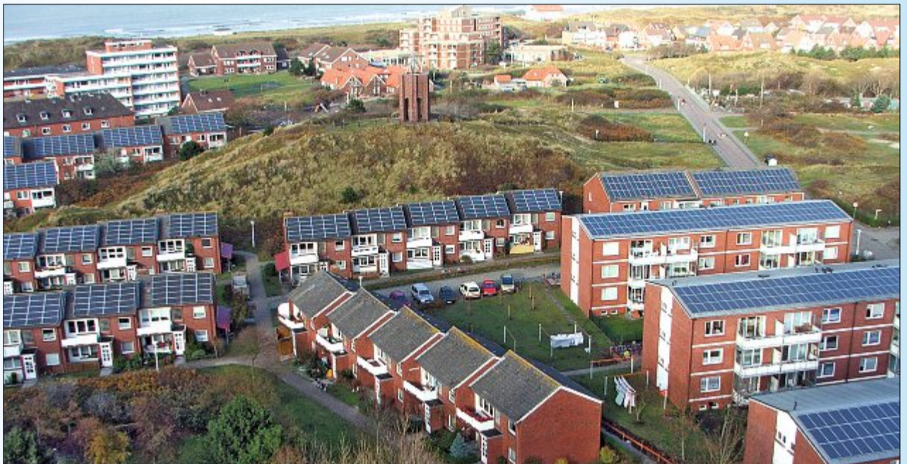
Viele Dächer der Insel sind bereits mit Fotovoltaikanlagen ausgestattet.
