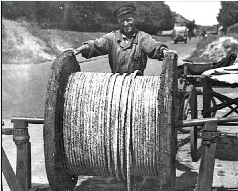
Stromleitungen am laufenden Band: Inselgäste gaben damals den Anstoß für die Elektrizität auf Norderney.
