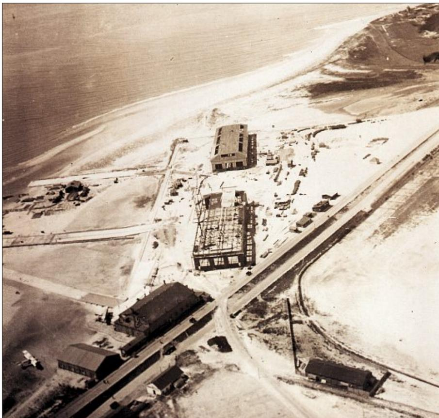
Die ersten Hallen sind im Rohbau fertig. Die Ablaufbahnen sind bereits zu sehen. Eine dieser Bahnen ist heute noch erhalten und wird für den Abtransport des Inselmülls gebraucht, von wo aus das „Landungsboot“ die Müllcontainer der Umschlagstation zum Festland bringt. FOTO: ARCHIV RÖBEN
