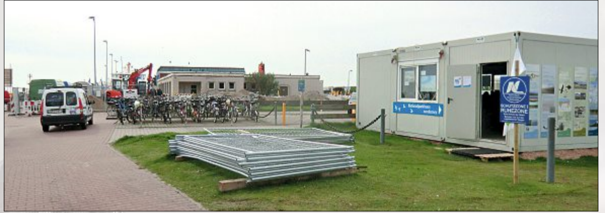
Während der Umbauphase ist das Team des Nationalpark-Hauses in einem Container untergebracht.
