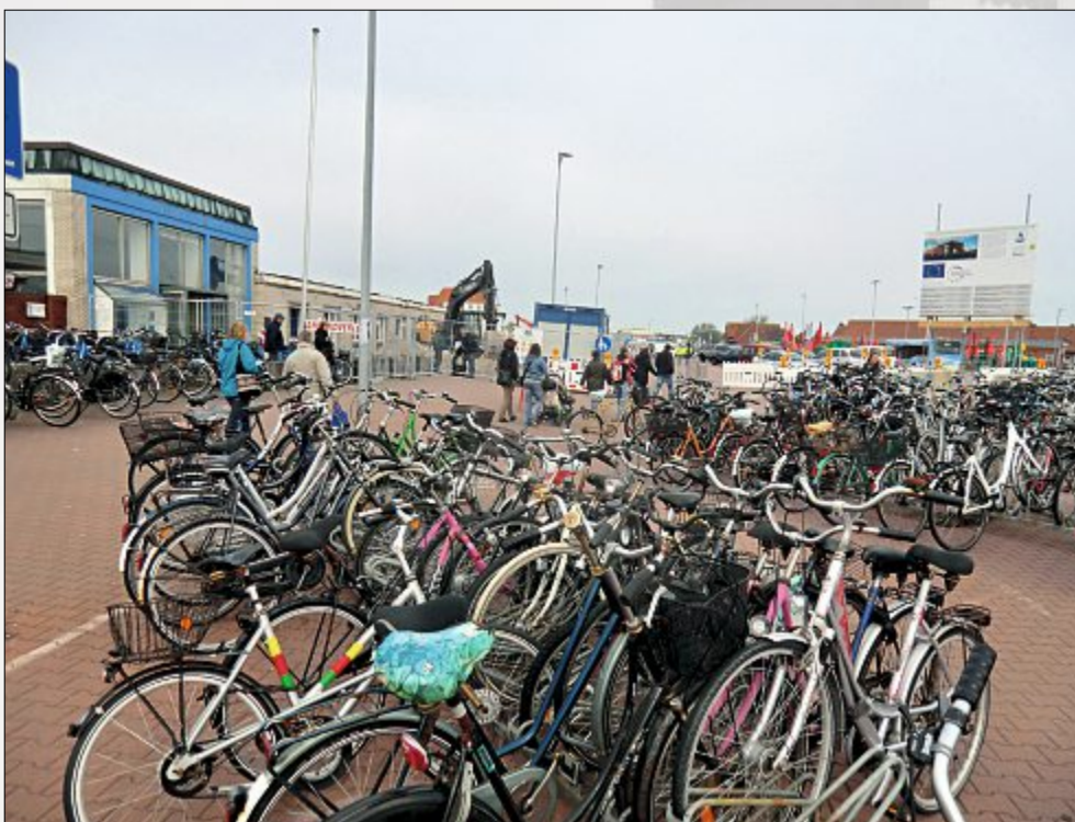
Für die Bauarbeiten wurden am Hafen alle Fahrräder umgestellt und auch die Autos mussten teilweise umgeparkt werden.
