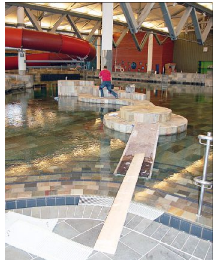
Im Familien-Thalassobad wurde innerhalb der Revisionsarbeiten fleißig gewerkelt. Seit heute ist das Bad wieder offen. FOTOS: ENGEL
