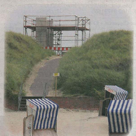
Die Arbeiten an der Aussichtsplattform sind noch nicht wieder aufgenommen worden.
