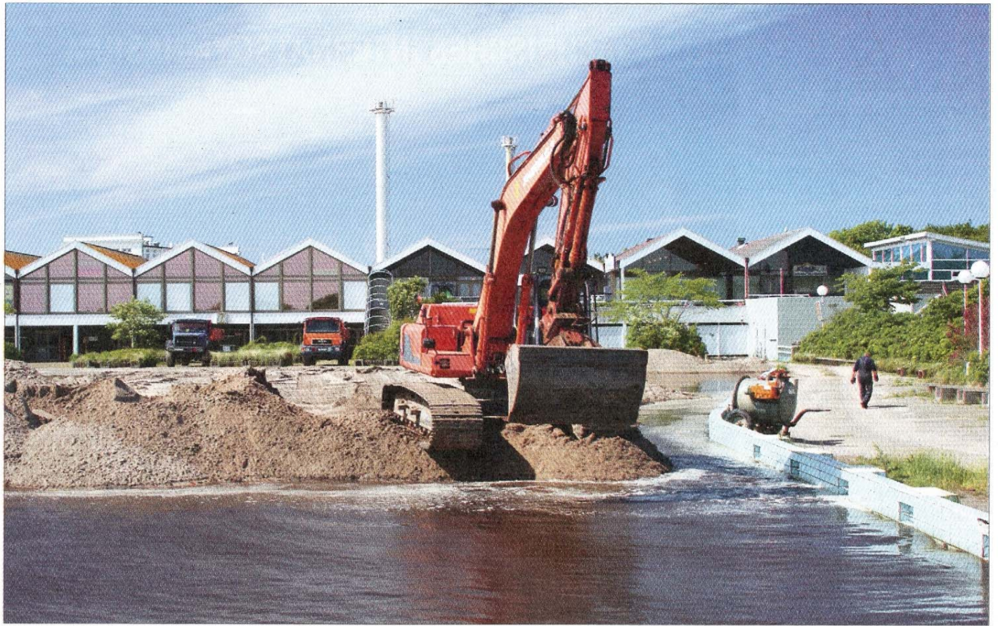
Eine Freibad-Ära endet: Das Badebecken wird mit Sand verfüllt.
