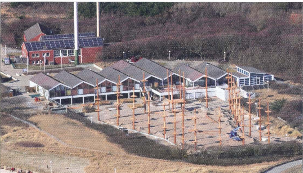
Die aktuelle Nutzung des Geländes als Klettergarten. Ansicht aus der Luft von Süden her. Im Hintergrund die Fassade der Freibadhalle mit den Einrichtungen: „Kükennest“, „Kleine Robbe“ und Bademuseum.
