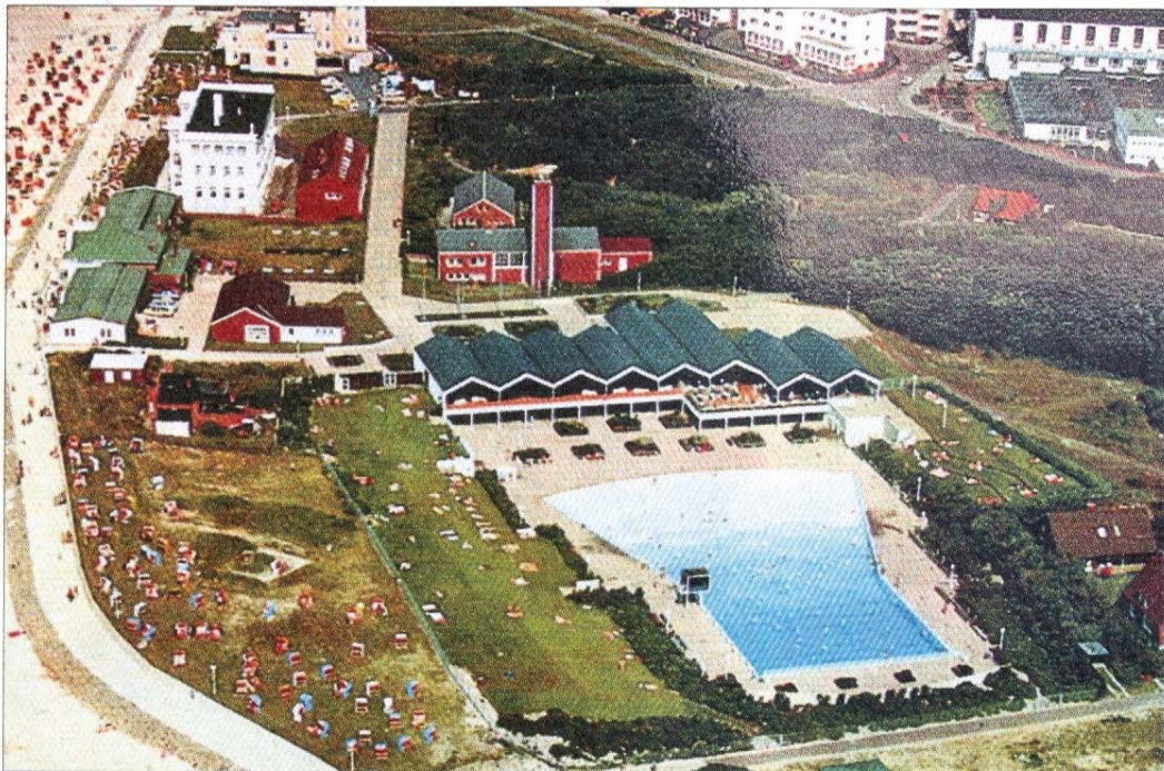
Das ehemalige Freibad mit der dahinterliegenden Energiezentrale. Der Badebetrieb fand von 1974 bis 2002 statt. Zuletzt im ungeheizten Becken.
