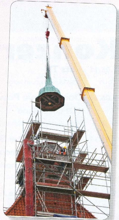
Die Spitze des Uhrenturms wird abgebaut.
