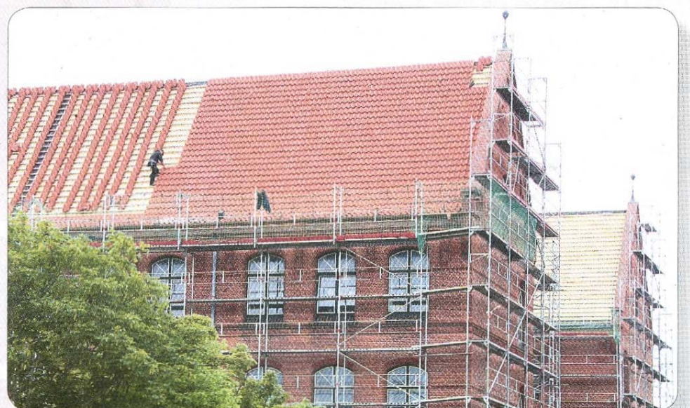
Zurzeit werden die neuen Dachziegel Stück für Stück verlegt.
