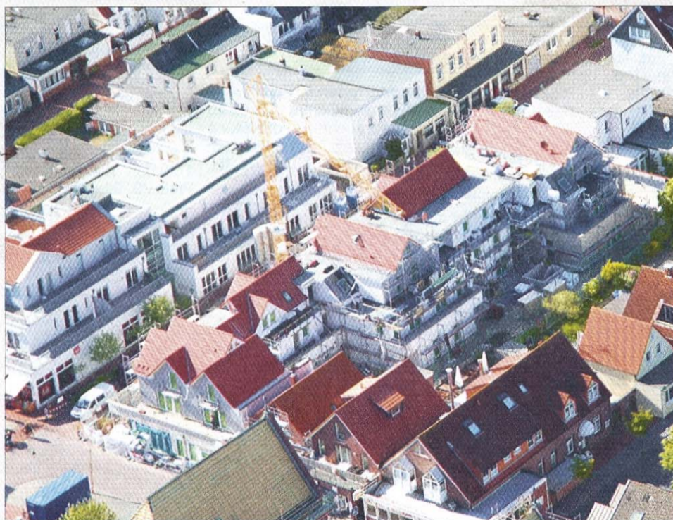
Das Gebäude auf der ehemaligen Grünfläche des Schullandheims Dresden an der Luciusstraße nähert sich der Fertigstellung.
