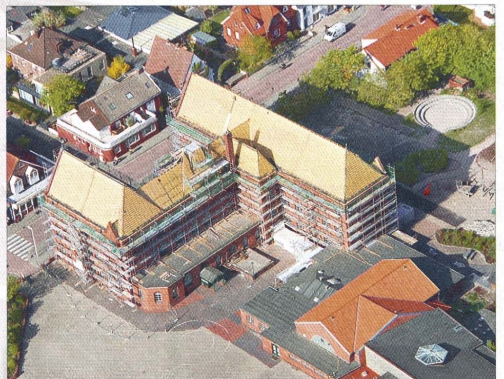
Die Grundschule wartet voll eingerüstet auf neue Dachziegel und den neuen Uhrenturm.
