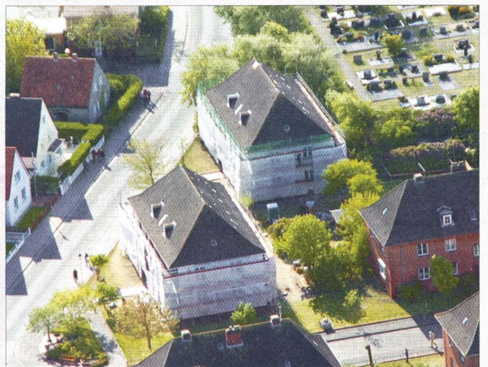
Die beiden Gebäude Ecke Mühlentstraße und Jann-Berghaus-Straße bekommen eine neue Außenfassade.
