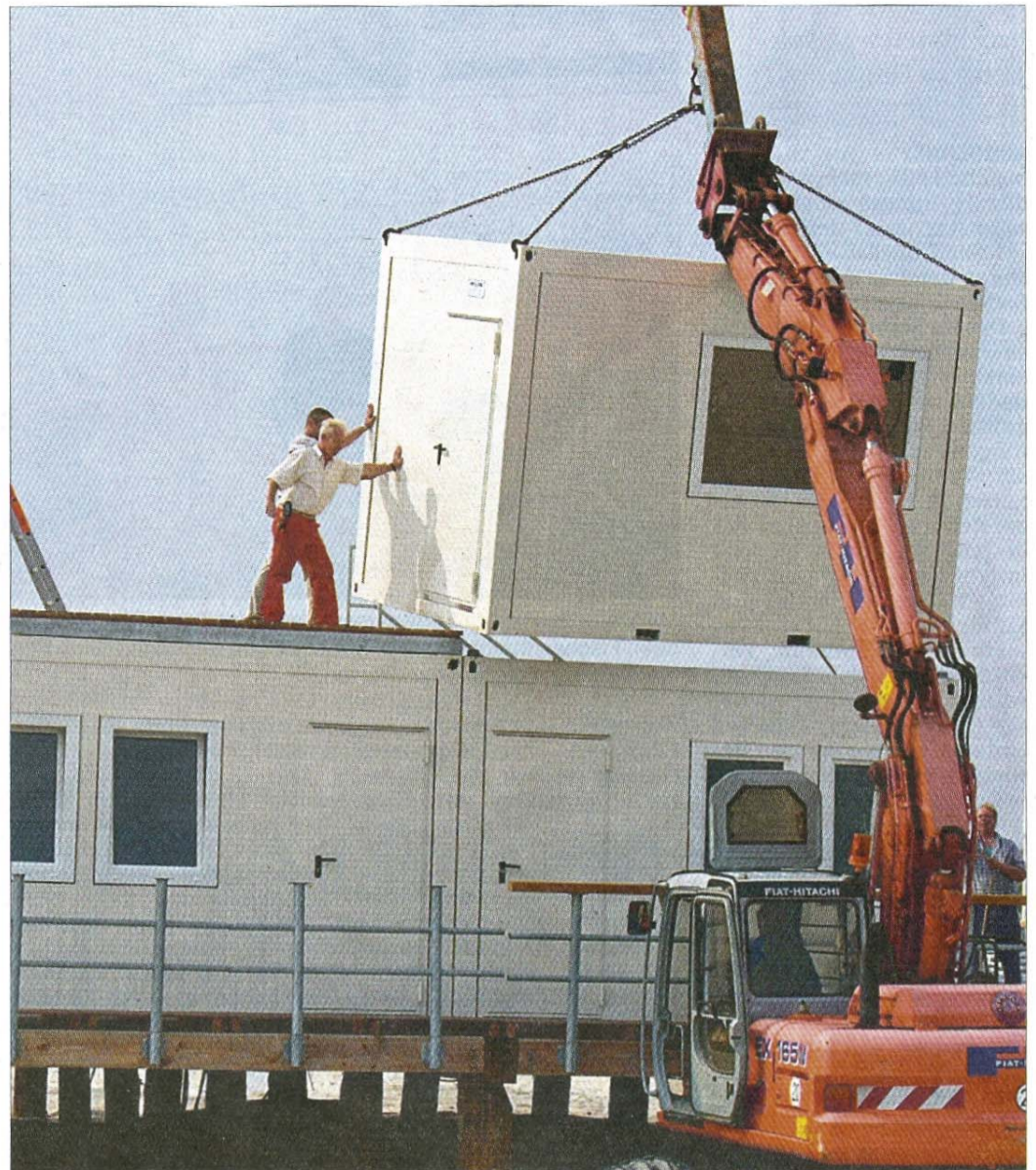
Montage der Container für die Saunaanlage in der zweiten Etage. FOTOS (4) : KARL-HEINZ HARMS
