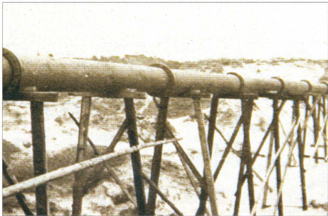
Aufgeständerte Rohrleitung.
