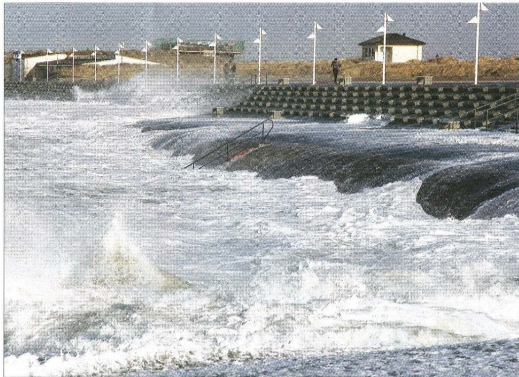
Nordstrand bei mittlerer Sturmflut. Nach Fertigstellung und Ergänzung des Deckwerkes werden die Wellen auf dem Höckerdeckwerk gebrochen. FOTO: NEYPIX
