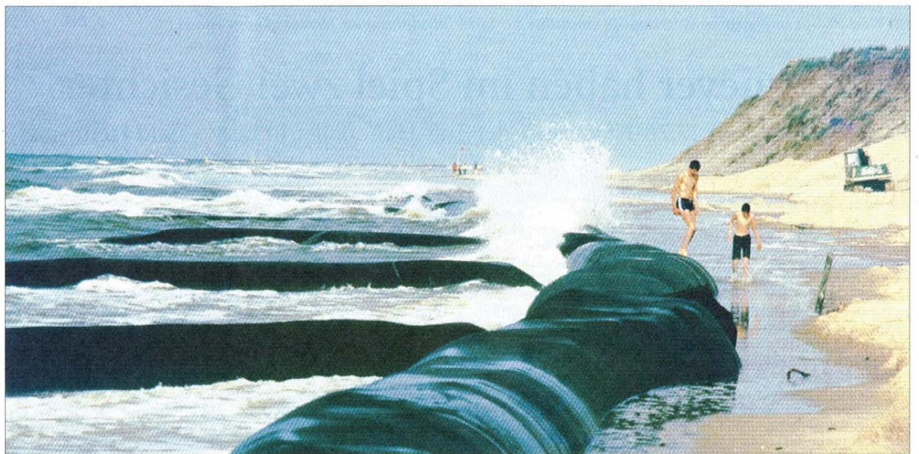
650 m langer mit Sand gefüllter Gewebeslauch zum Schutz der Einbruchsstelle.
