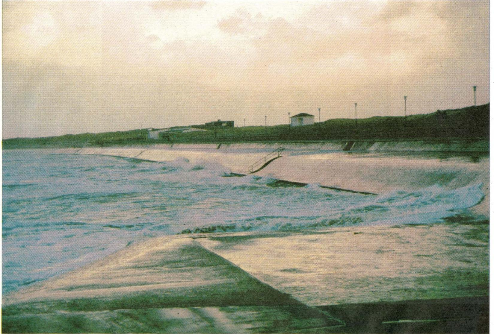
Mittlere Sturmflut am Nordstrand. Das neue Schrägdeckwerk lässt die Wellen sanft auslaufen und nimmt ihnen die Wucht. Der Sandtransport in Richtung See wird abgemildert, die Strandhöhe nimmt nicht so schnell ab. FOTOS: SAATHOFF
