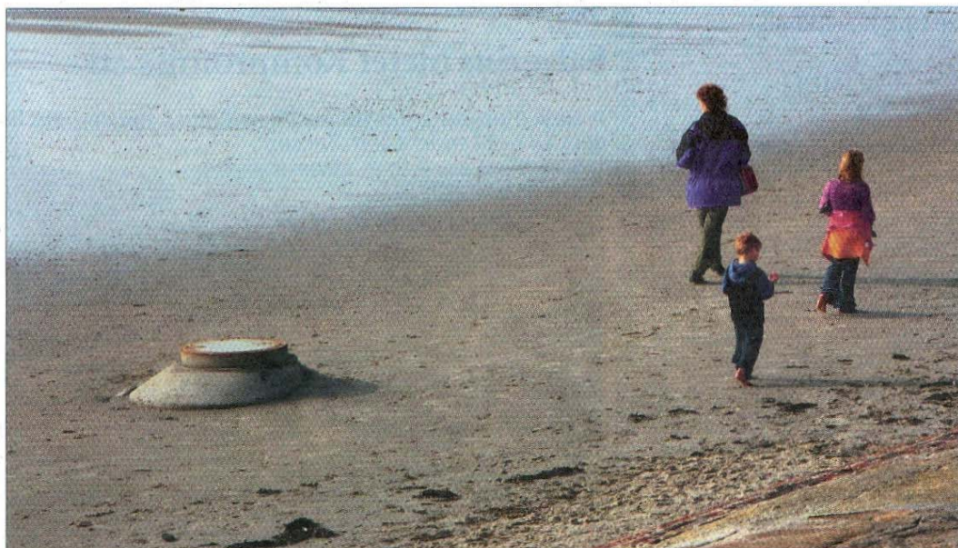
Über die Seewasserleitung, deren Anschluss-Stützen am Strand von Norderney zu sehen sind, wird das Norderneyer Badehaus stets mit frischem Meerwasser versorgt.
