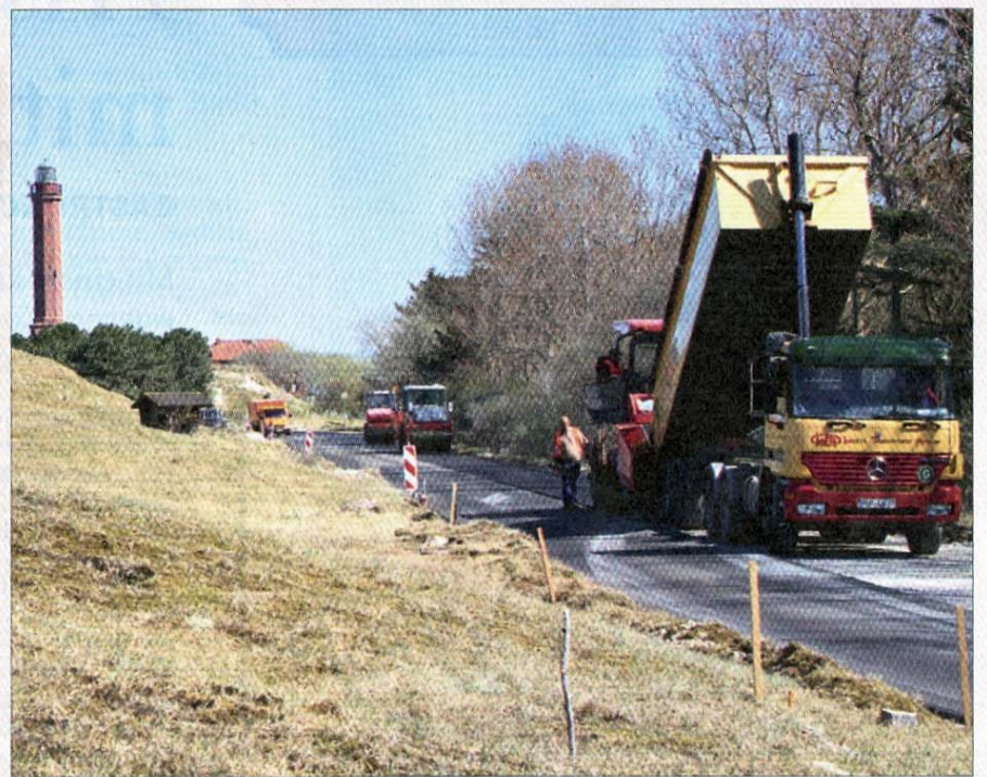
Die linke Straßenseite ist mit der ersten Asphaltsschicht bereits bedeckt, rechts ist noch der Schotteruntergrund für die neue Fahrbahn deutlich erkennbar.
