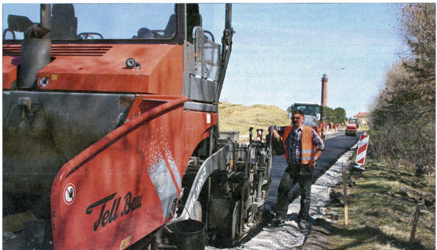
Mit dem Leuchtturm im Rücken überwacht dieser Bauarbeiter die Aufbringung des Asphalts auf die Straße. FOTOS: SAATHOFF
