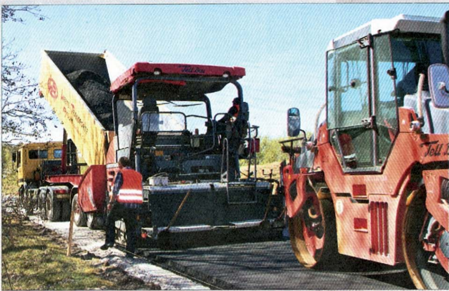
Mit schwerem Gerät wird die Asphaltsschicht aufgetragen.
