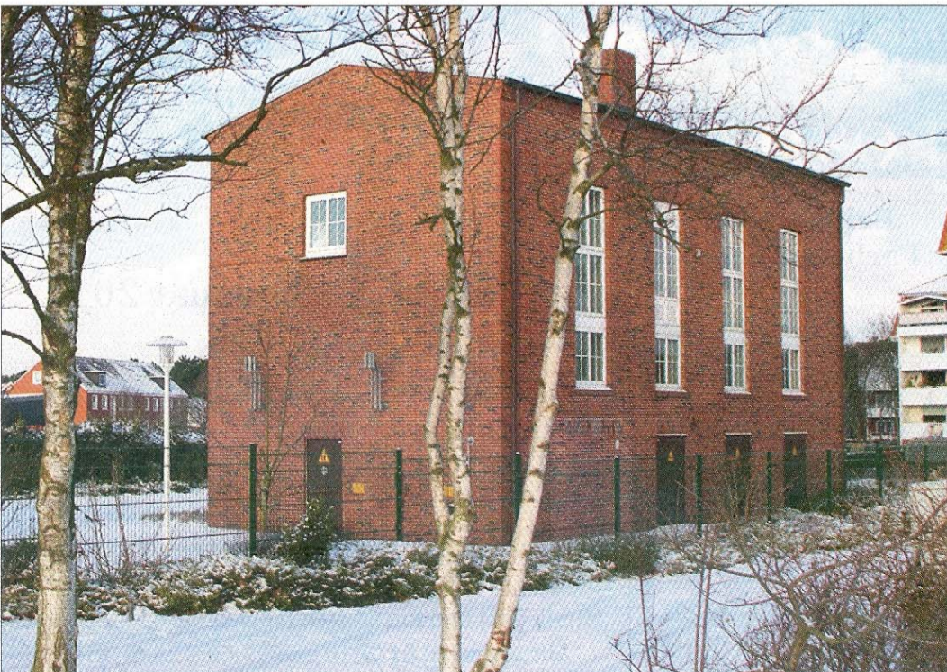
Die neue Gasreglerstation an der Südstraße.
