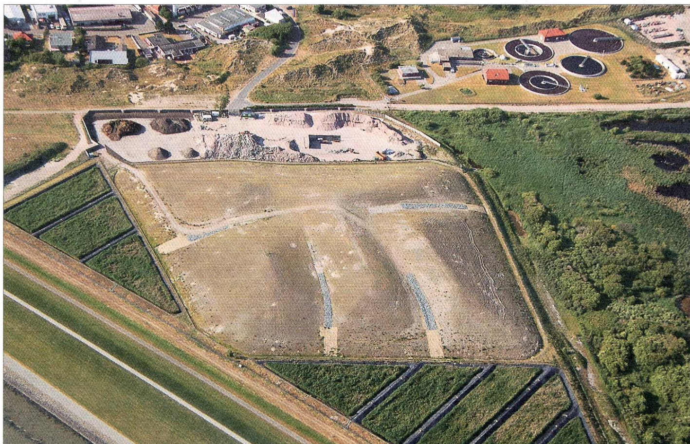
Luftbild der rekultivierten Deponie Südstrandpolder. Im Vordergrund die Vererdungsbeete, im Hintergrund die Recyclinganlage und das Klärwerk.
