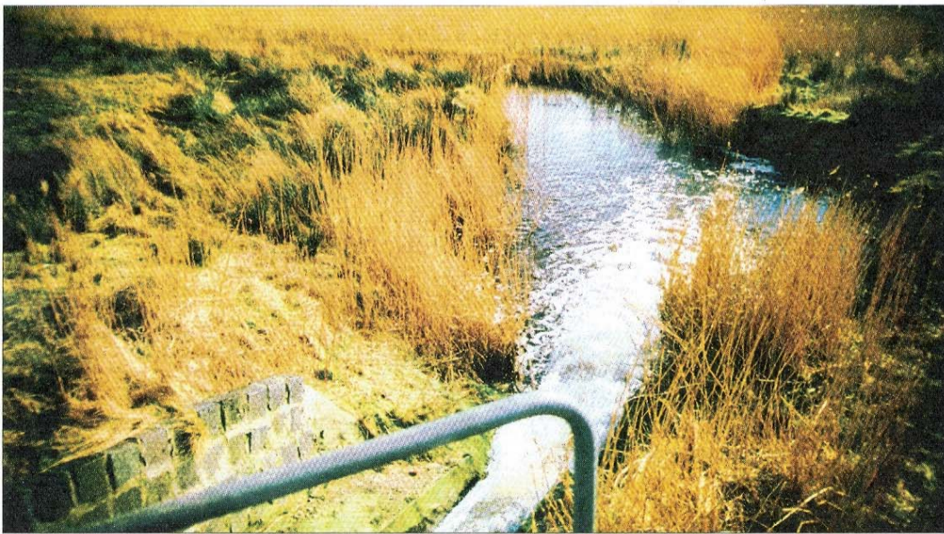
Klärwerks-Auslauf in das Schilfgebiet Südstrandpolder.
