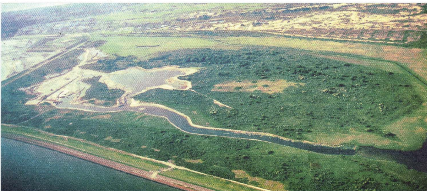
Teichanlage Südstrandpolder kurz vor der Fertigstellung.
