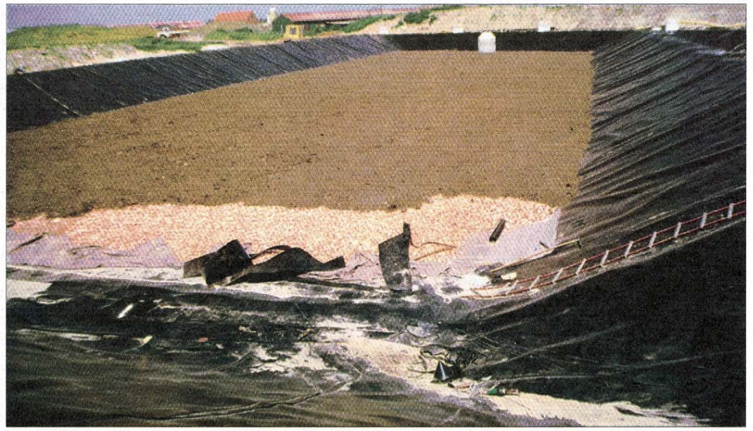
Vorbereitung eines Vererdungsbeetes mit Filterschicht und Pflanzsubstrat.
