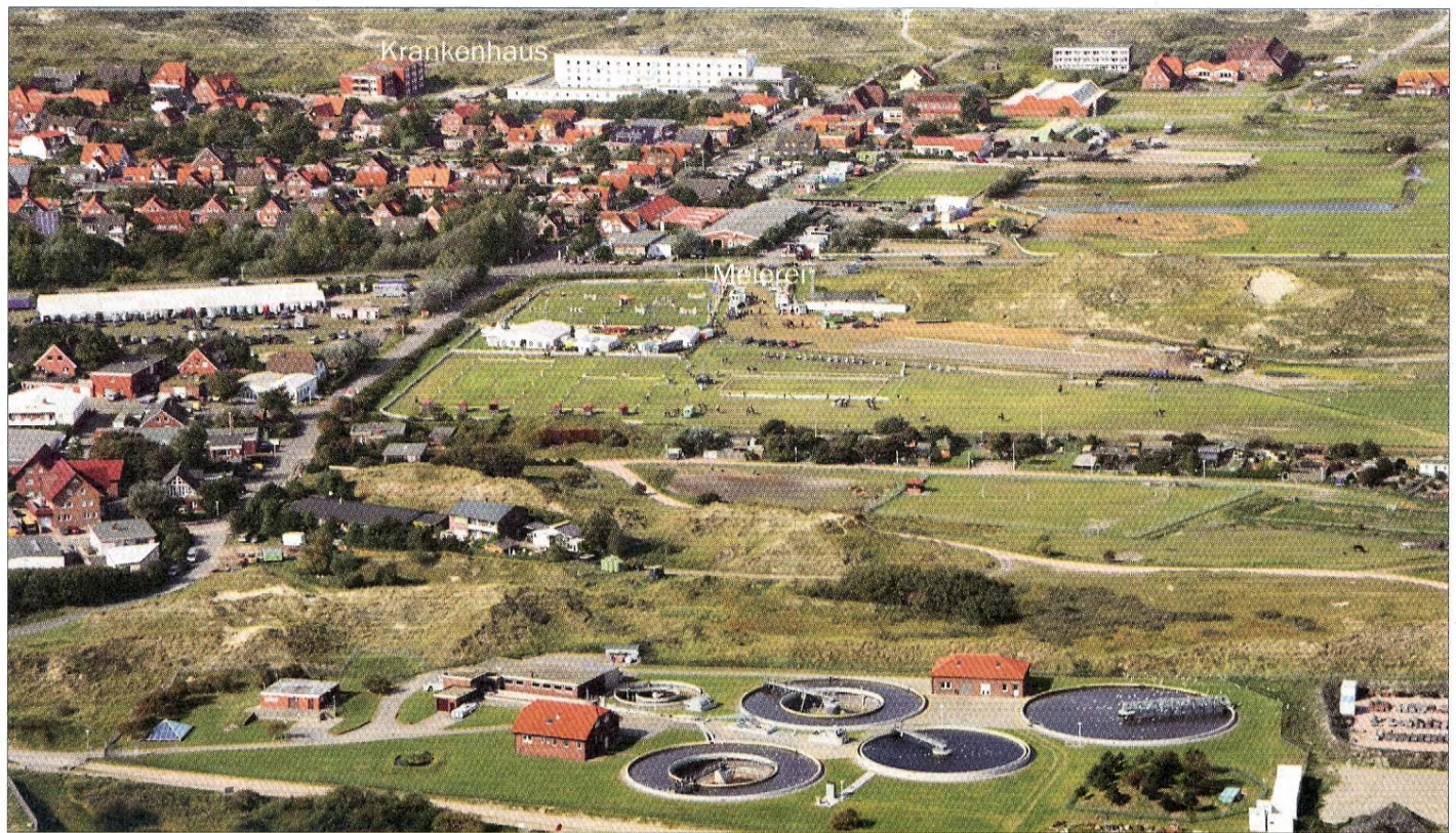
Das Klärwerk heute (unten) – darüber die Meierei und ganz oben das Krankenhaus.
