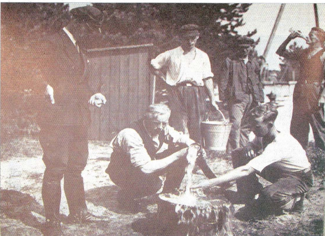
Betriebsingenieur Friedrich Müller (links) begutachtet einen Brunnenbau auf Norderney.
