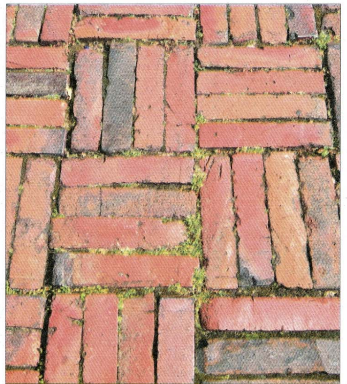
Klinkerpflaster im Paketverband verlegt.
