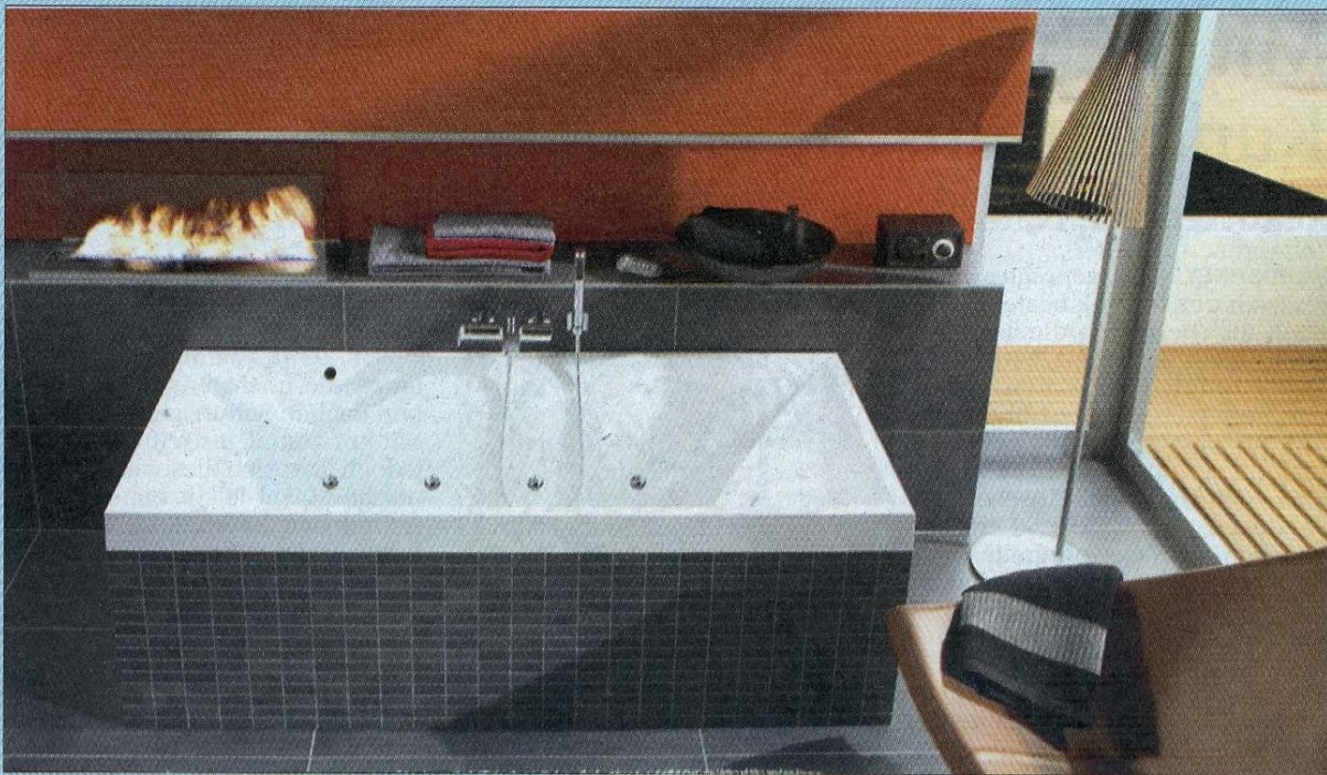
Die moderne Komforttechnik versteckt sich in der Wand.
